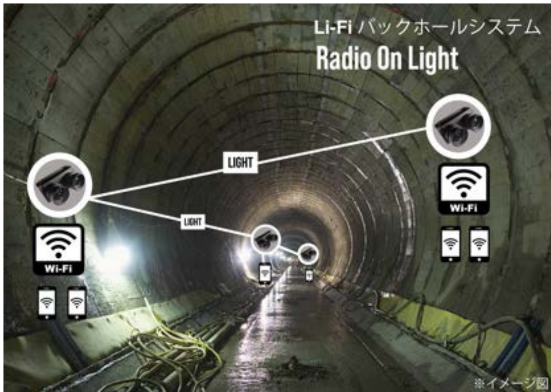
建設現場などの不感地帯における通信インフラ
